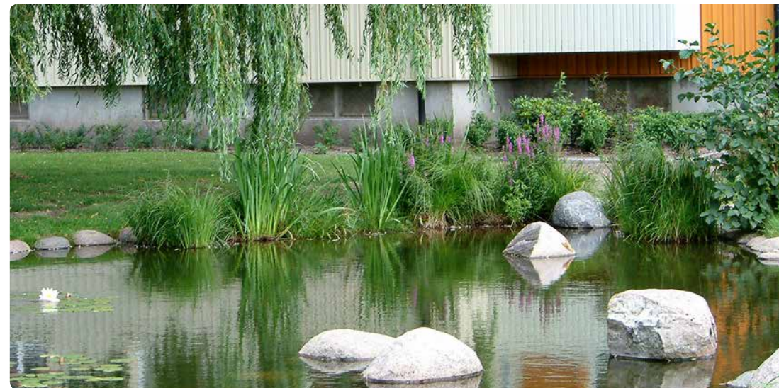
Trög avledning, svackdiken, har anlagts i ett befintligt bostadsområde i Augustenborg, Malmö.
