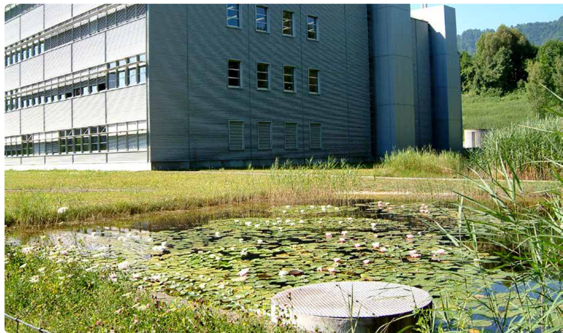
Dagvattendamm vid en industribyggnad i Zürich.
