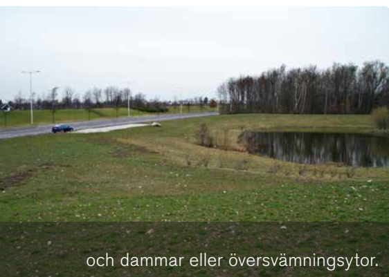
till att leda vägdagvatten till svackdiken...
