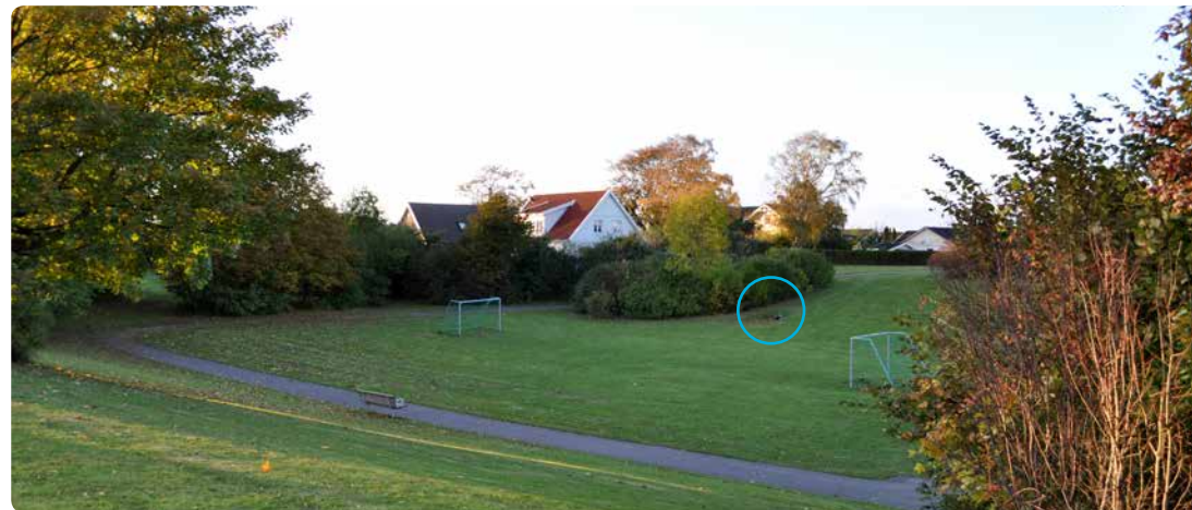
En park i Lomma används både som översvåmningsyta vid stora regn och som fotbollsplan. Bräddavlopp från ledning till översvåmningsyta är inringad.
