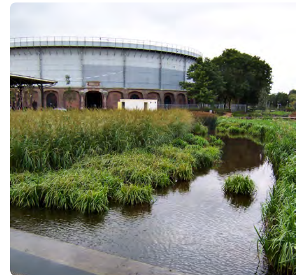
Vegetation i dagvattendammar leder till bättre rening av dagvattnet bl a genom att vattnet filtreras och att växterna ger stora ytor att leva på för mikroorganismer, som bryter ner föroreningar. Foto: Siv Degerman
