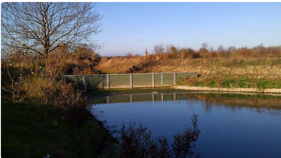
Oljeskärm i en sedimentations- och fördröjningsdam är ett sätt att avskilja olja och flytande skräp. Foto: Sofia Hedström
