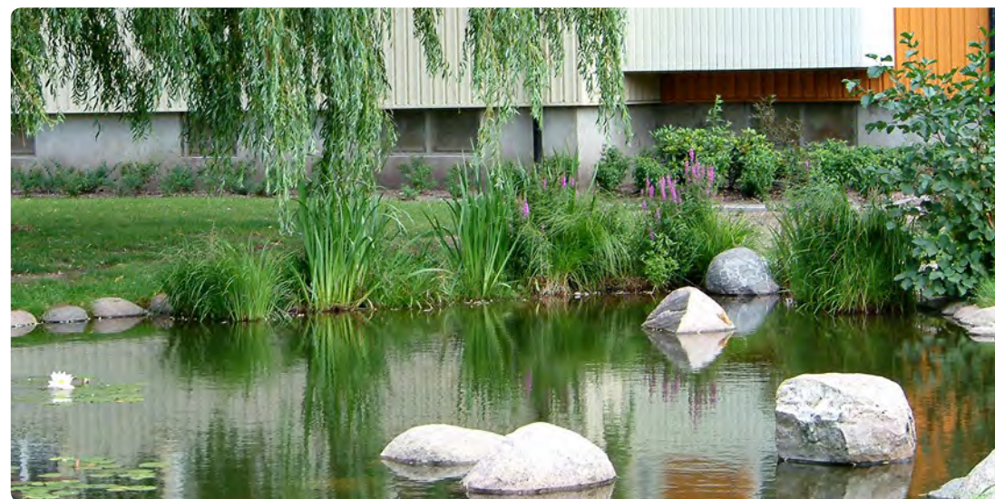
Dagvattendamm på gård vid flerbostadshus i Malmö.
