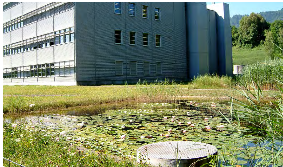
Dagvattendamm vid en industribyggnad i Zürich.
